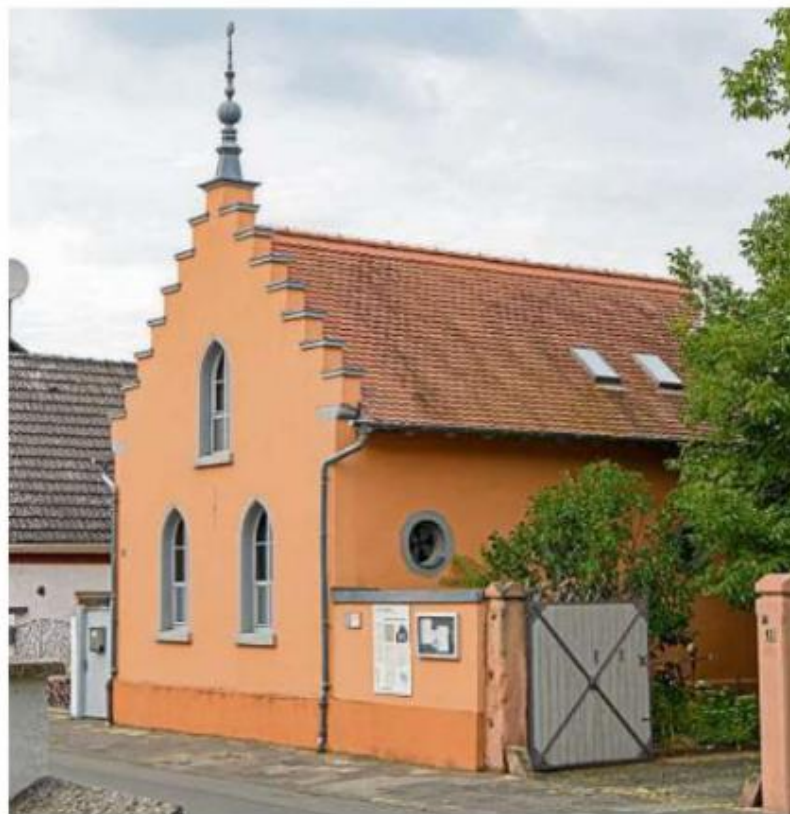
In der ehemaligen Synagoge in Erfelden soll der Eingangsbereich neu gestaltet und die Heizung erneuert werden. Foto: Robert Heiler
