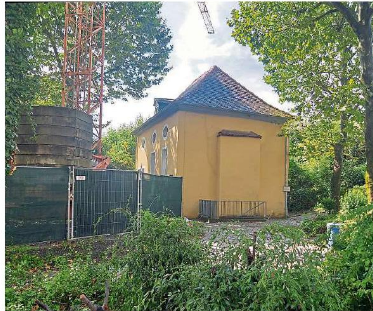
Derzeit fällt die ehemalige Auerbacher Synagoge noch weniger als sonst ins Auge, da sie seit fast drei Jahren von einer Baustelle verdeckt wird. Aber eine Tafel direkt an der Bachgasse informiert über die Geschichte des Gebäudes.
